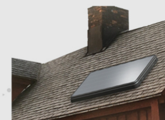
INSTALLAZIONE SUL TETTO A FALDE
